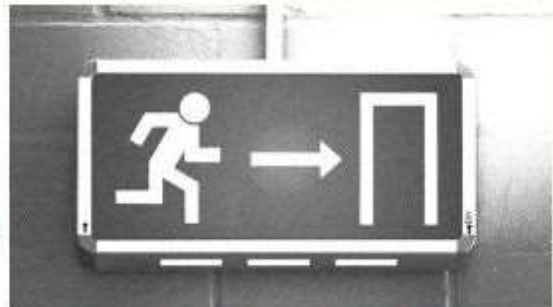
Notausgang-Schilder demnächst überflüssig?
